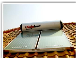
Sebuah penyempurnaan atas system direct heating Solahart yang telah terbukti tangguh, Super L mempergunakan kolektor penyerap panas dengan 12 alur dan cat khusus Thermal Solar Paint yang terbuat dari 100 % Silicone Polymer untuk mempercepat pemanasan air.
